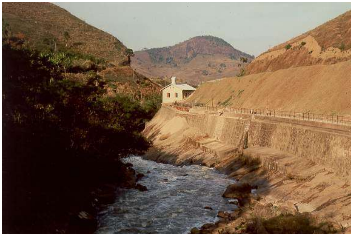
Figura 1: Usina de Marmelos Zero, inserida na margem do Rio Paraibuna.
