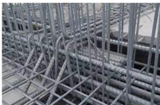
Figura 9: Concreto armado (armadura de aço)
