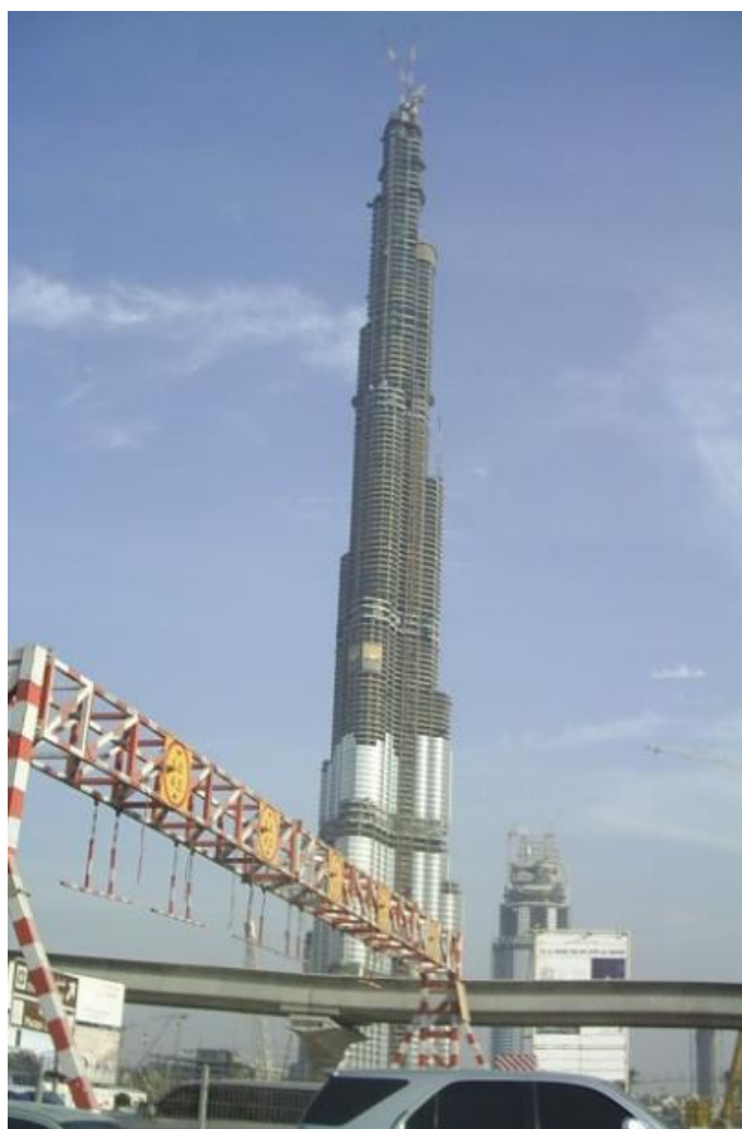
Figura 10: Burj Khalifa, Dubai, Emirados Árabes (em construção em 2007)
