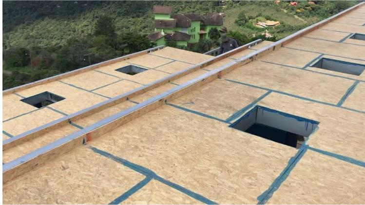
Figura 12- Laje seca com placas OSB.
