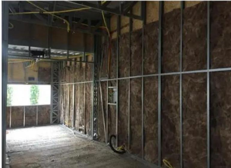
Figura 29: Isolamento termo-acústico.
