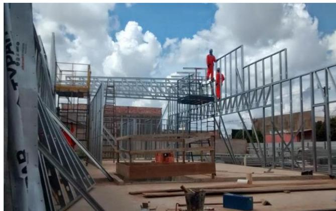
Figura 3: Montagem por painéis pré-fabricados.
