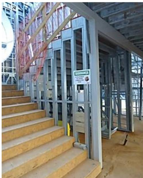
Figura 18: Escada executada com o método de painéis escalonados.
