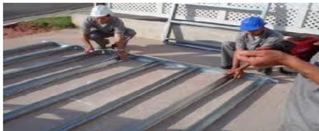
Figura 2: Montagem de painel em *Light Steel Framing* no canteiro de obras.
