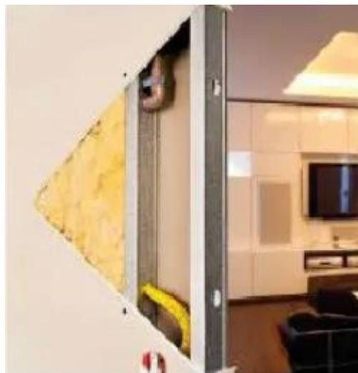
Figura 24: Detalhes de tubulações elétrica e hidráulica no *Light Steel Frame*.
