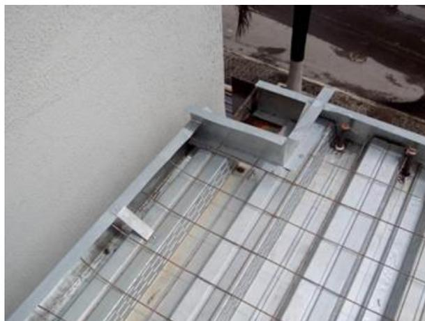
Figura 11- galvanizado tipo cantoneira no perímetro da laje.
