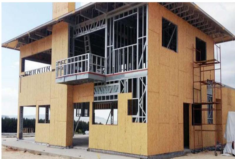
Figura 30: Fechamento externo com placas OSB.
