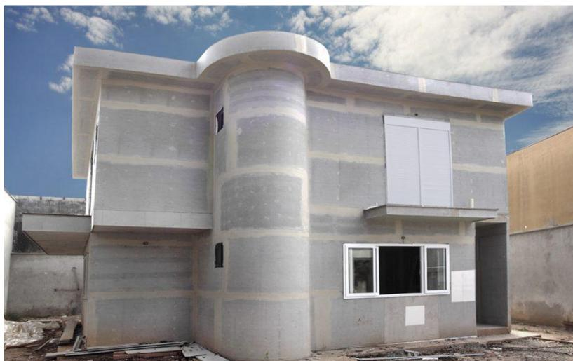
Figura 31: Fechamento externo com placas cimentícias.
