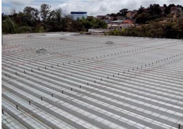
Figura 10- Fôrma de aço de laje úmida tipo *Steel Deck*.
