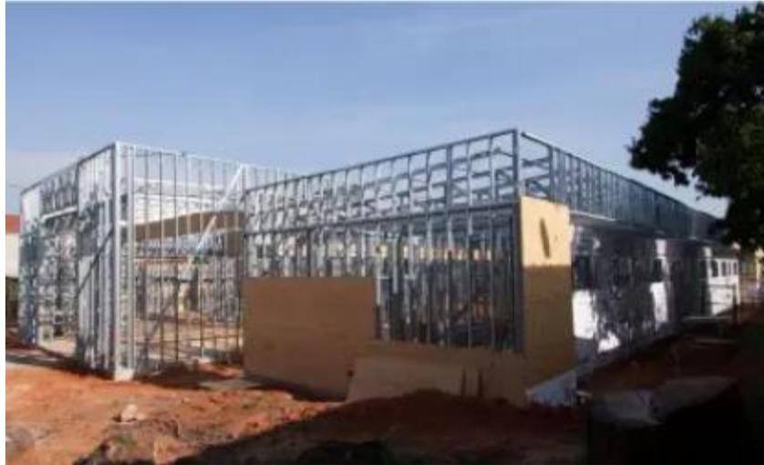
Figura 23: Execução montagem LSF.
